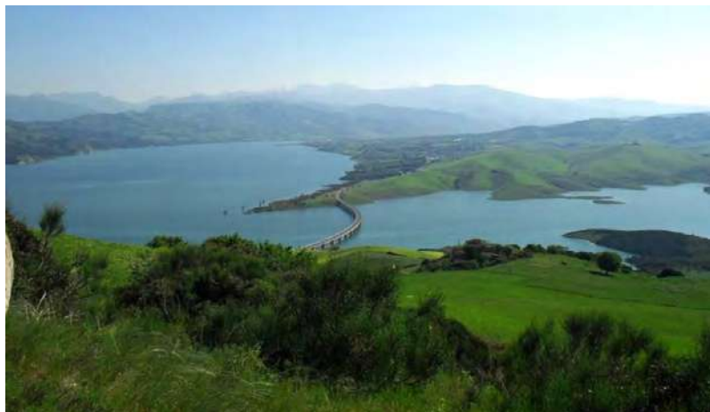
Diga di Monte Cotugno, Senise (PZ)
